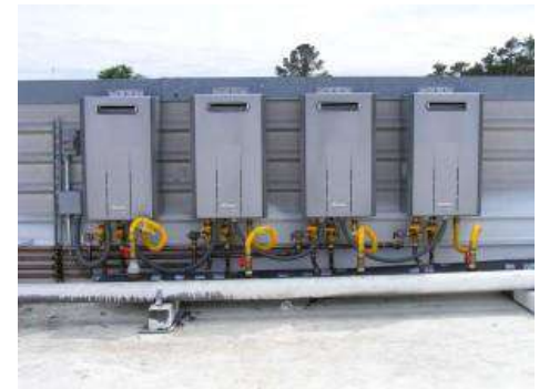
Calentadores instalados en serie en exterior
