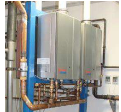
Calentadores instalados en serie en interior
